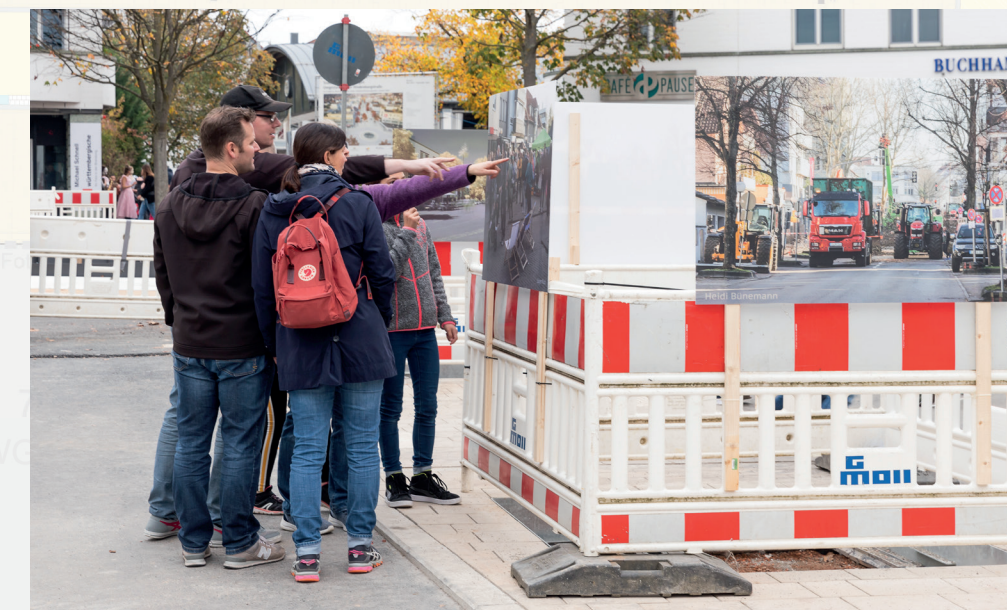
Großformatige Aufnahmen der Baustelle schmücken das Baufeld.
