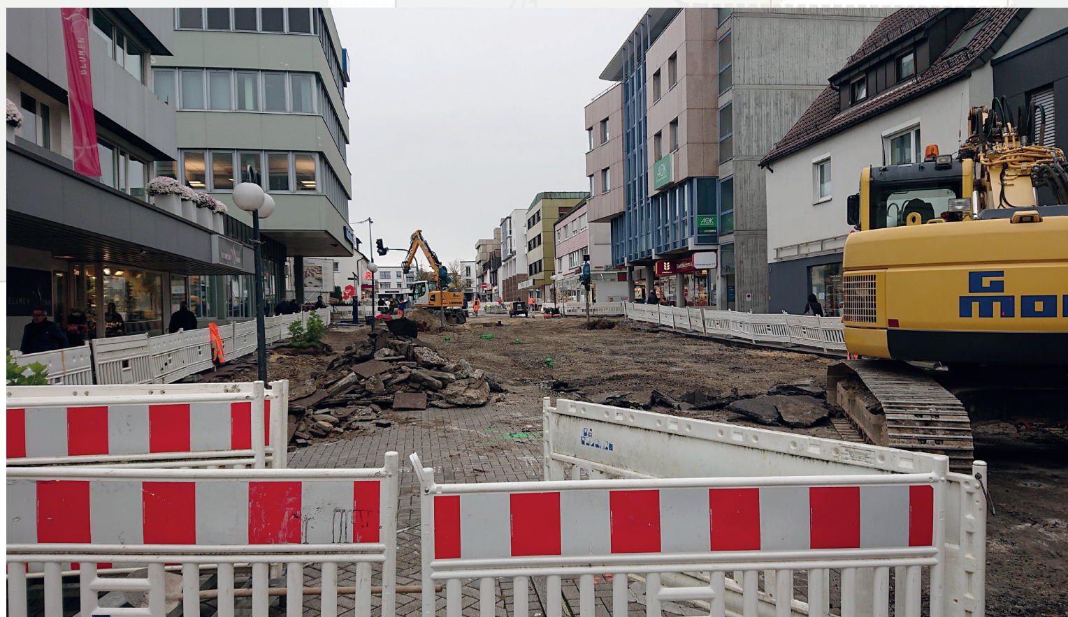
Die Arbeiten am neuen Bauabschnitt der Hindenburgstraße sind in vollem Gange.
