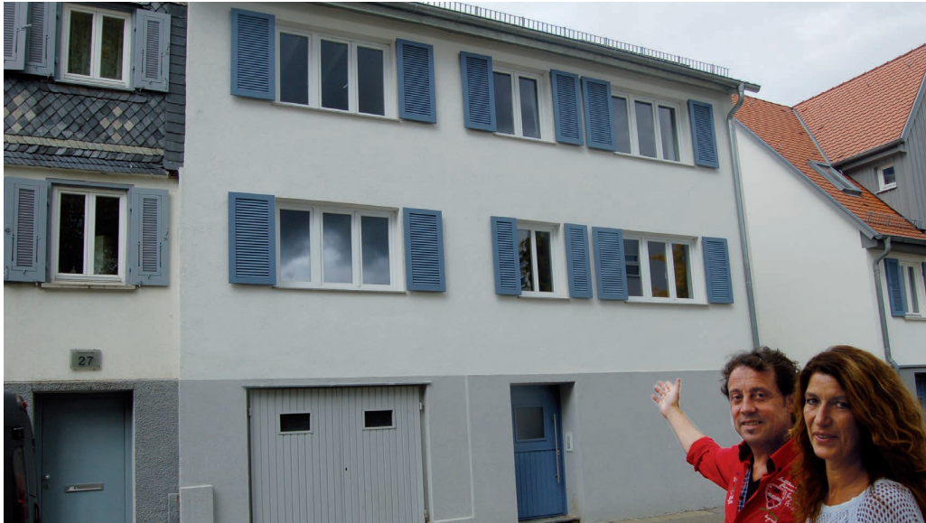
Dank Fördermitteln ist die Sanierung umfassend gelungen.
