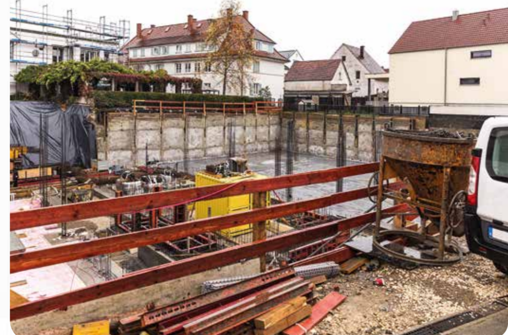
Baustelle Esslinger Straße 18.
